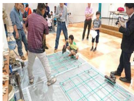
基礎(鉄筋組み)
